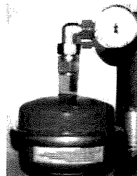
26. ábra: Táglási tartály nyomásmérővel
